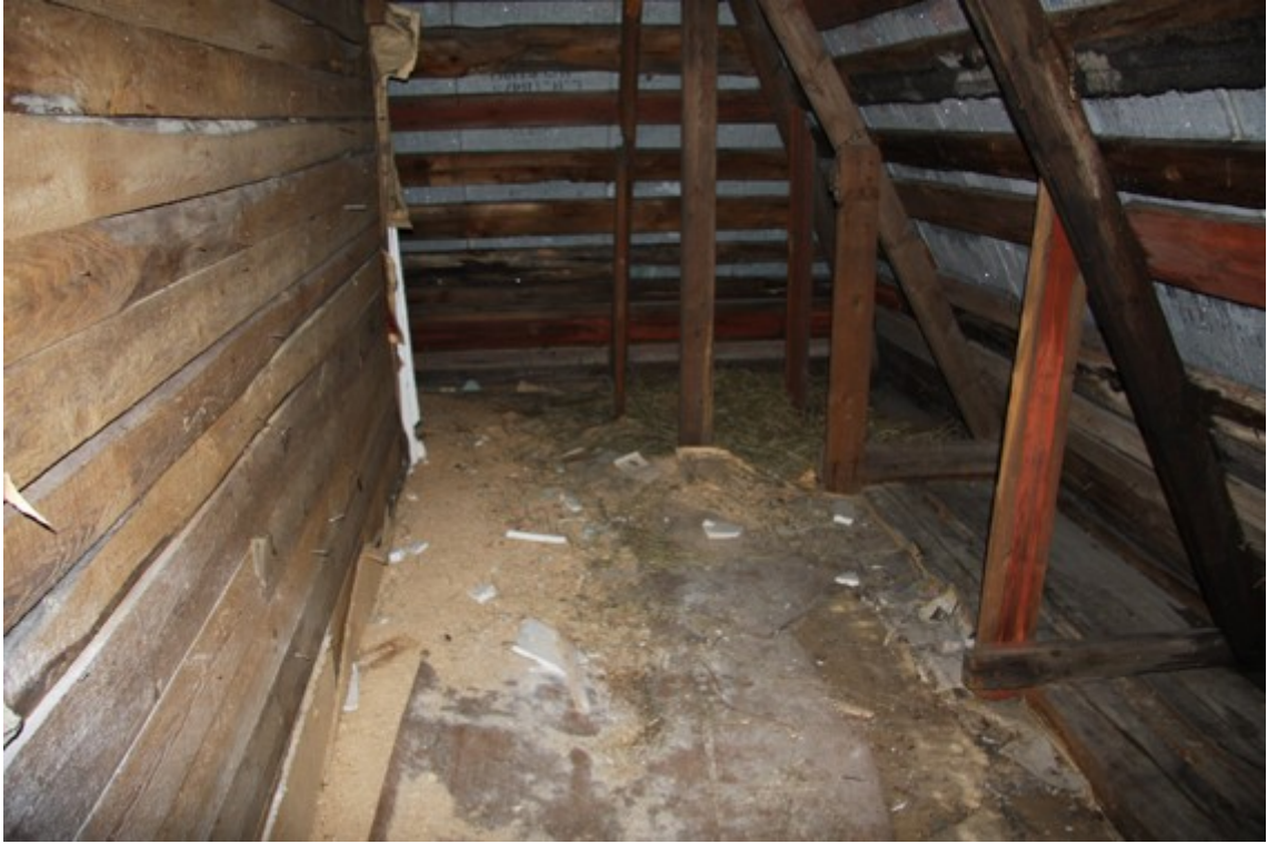
Kuva 2. Yläkerroksen puruvintti.©Timo Metsänen
